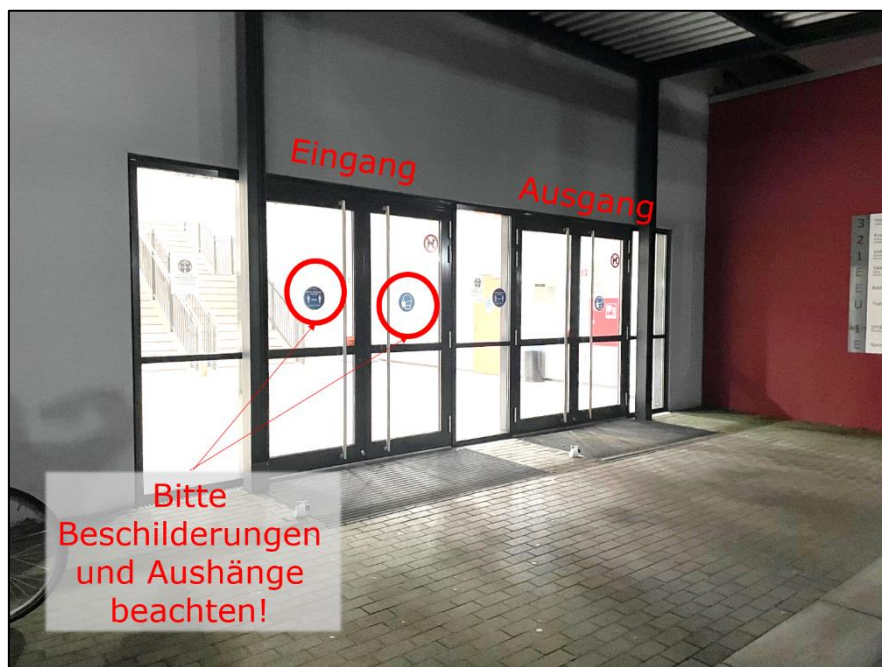
Abbildung 2: Eingangsbereich der Sporthalle und Zugang zu den Tribünen
